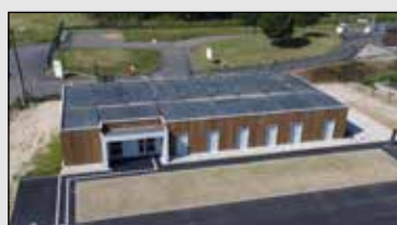
les locaux administratifs
